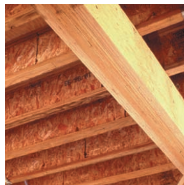
一个四层单板的单板层积材大梁用作承载梁
