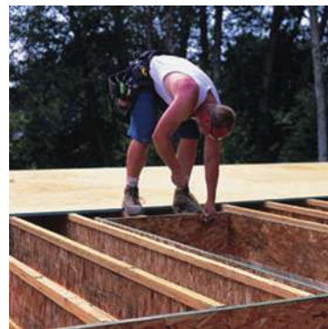
工程木楼板系统，包括了封边梁，是住宅和轻型商业应用的一种节省成本的系统。
