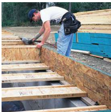
常见的OSB封边梁与底梁板紧密结合，采用面钉与工字木搁栅翼缘以及端部连接，采用斜钉与地梁板连接。
