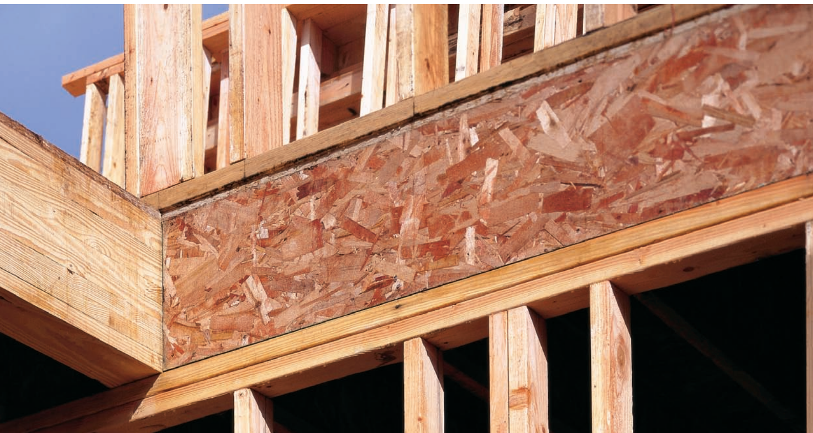
常见的OSB封边梁与底梁板紧密结合，采用面钉与工字木搁栅翼缘以及端部连接，采用斜钉与地梁板连接。
