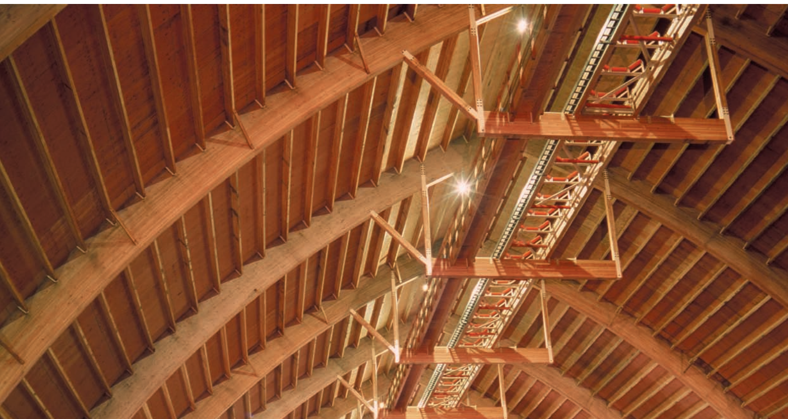
胶合木是唯一能够进行起拱的工程木产品。起拱后的构件可以减小因使用变形而产生的美观上的影响。
