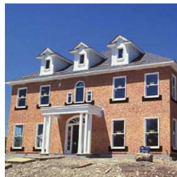
墙体完全采用定向刨花板覆面板，极大地提高了墙体的抗变形能力以及抗剪强度
