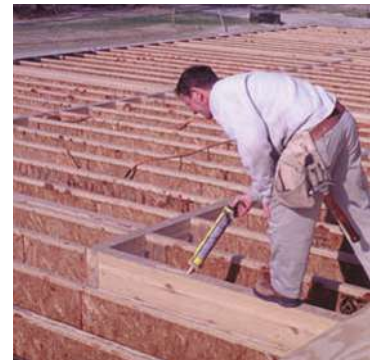
工字木搁栅因比规格材托梁具有更卓越的性能，而被用在住宅和轻型商业楼板应用中。
