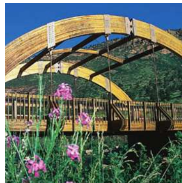
防腐处理后的胶合梁产品可以在户外暴露条件下应用，如桥梁、电线杆、十字支撑梁，以及码头。
