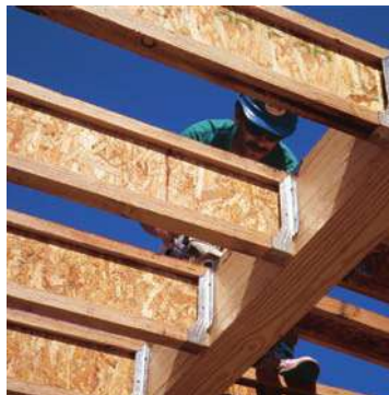
工字木搁栅因其稳定的性能，而用来制造成住宅建筑中使用的特殊宽度。
