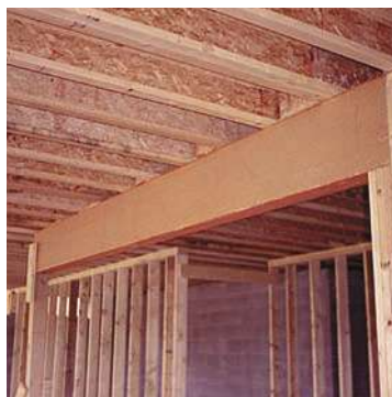
单板层积材用作支撑上层楼板的坚固的过梁
